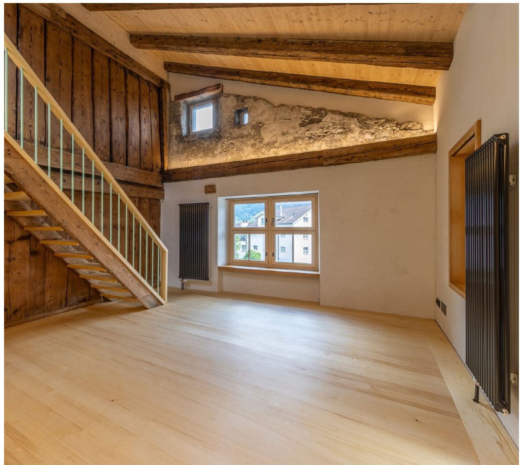
Innenliegende Bohlenständerbauweise mit offenem Dachgeschoss, neuer Dachaufbau.
