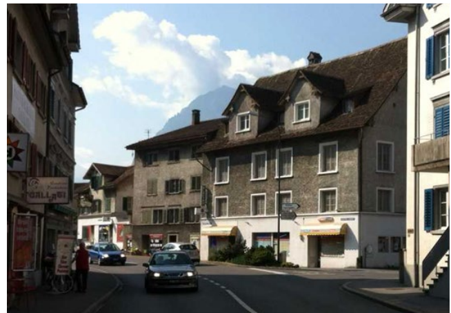
Dorfzentrum Näfels mit den drei «Beugehäusern» vor der Restaurierung.
